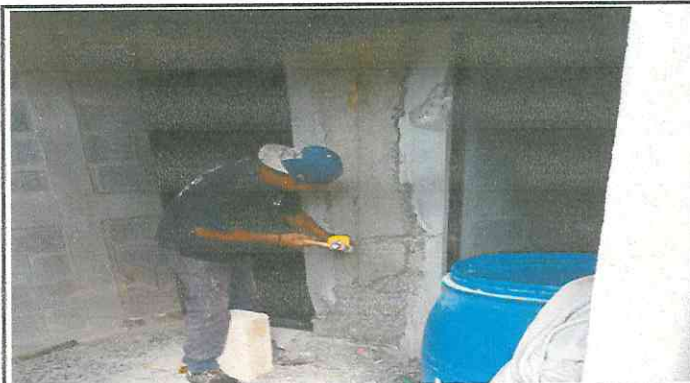
Foto 4: Remosamiento de baños
